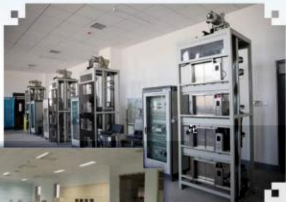
智能电梯安装调试 维护训练场所
